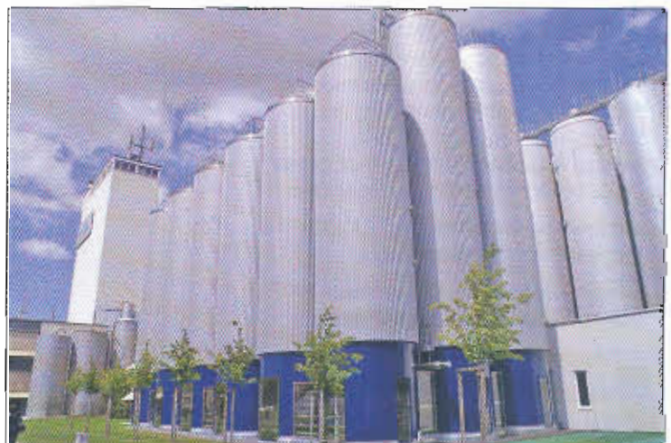
Die Tankfarm der Gesamtproduktion besteht aus vier Hefereinzuchttanks, 28 Gär- und Reifetanks, 32 Lagertanks untergärig und 18 Tanks für die obergärige Produktion.
