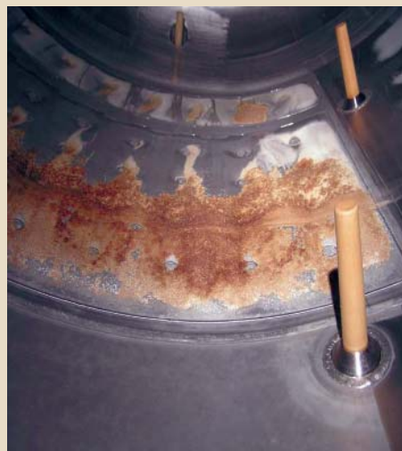
Abb. 1 Reinigungserfolg des Ziemann-Imeca-Systems (ZIS)
