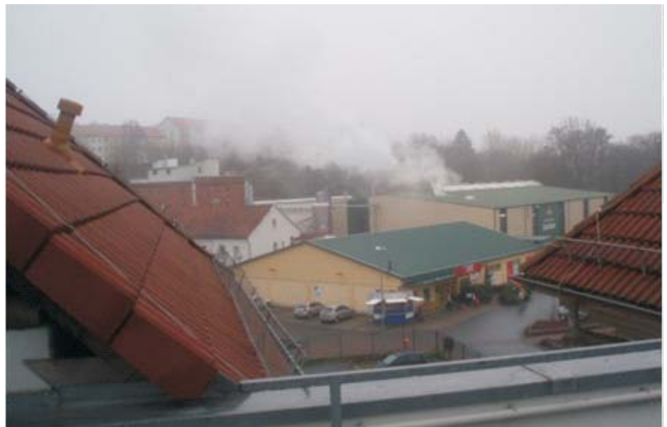
Abb. 1: Blick vom Parkdeck eines Einkaufszentrums auf den Sudhausneubau (die Schwadenfahnen der Würzpfanne und der Flaschenwaschmaschine ziehen Richtung Marktplatz)
