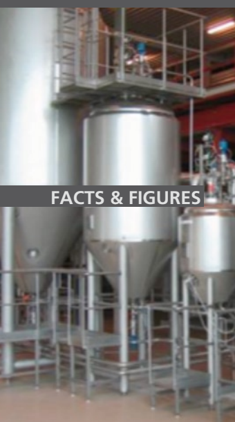
Klassische Hefereinzucht – mit Sterilisator, Propagator und Vermehrungsgefäß
