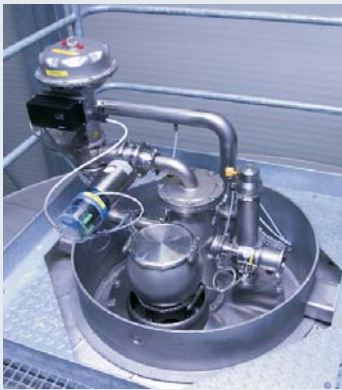
Tankanbindung im Kopfraum (Tanktop) für CIP/Gas-Management
