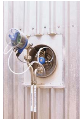
Die tankbündige Ventil-anordnung ermöglicht eine optimale tankseitige Reinigung.
